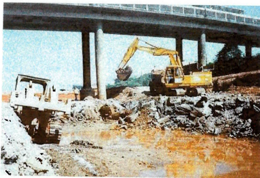
Figura 5: Obras na região de Osasco, na altura da ponte Piratininga, em Outubro de 1999.
